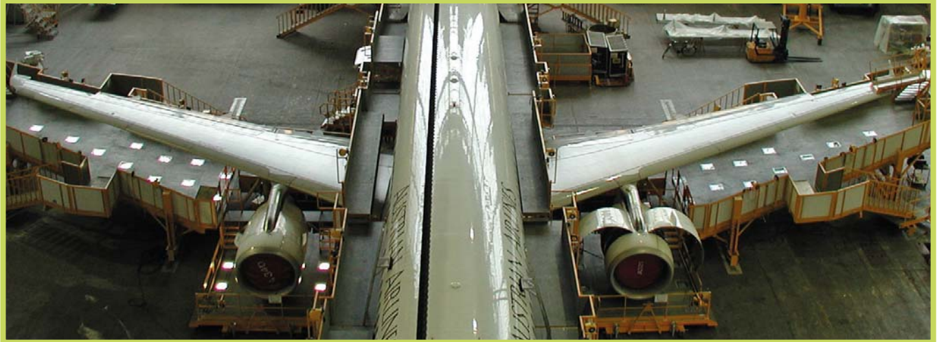
Prima LED - Beleuchtung der Trockendocks für die Flugzeugwartung
